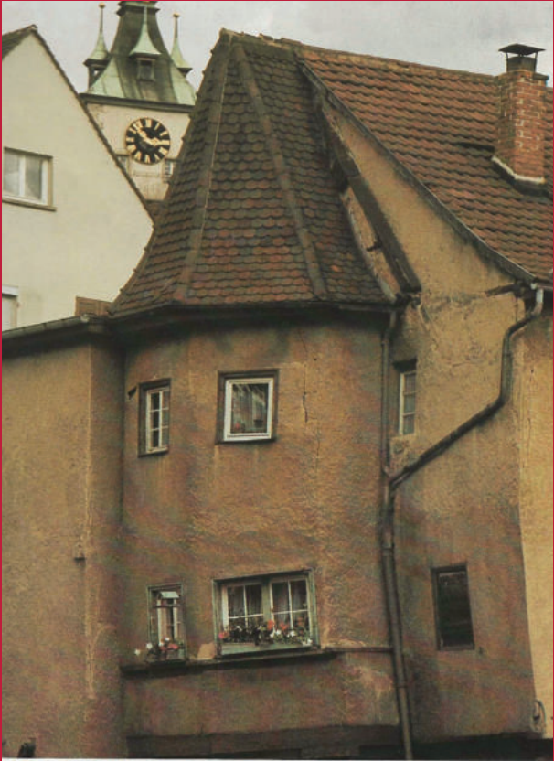
Stuttgarts ältestes Wohnhaus vor der Sanierung: Das Klosterle im Jahre 1979
